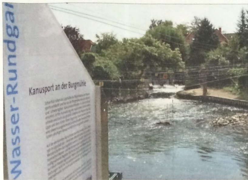
Seit der Flutkatastrophe 1965 sind Millionen in den Hochwasserschutz geflossen. Was immer noch fehlt: der Neubau des Stiftswehrs an der Burgmühle. Anfang September will die Bezirksregierung Arnsberg den vorliegenden Genehmigungsentwurf mit der Stadt und den Stadtwerken diskutieren. Geht alles klar, könnte der Neubau des Stiftswehrs 2018/2019 fertig sein. ■ Archivfoto: Prange
